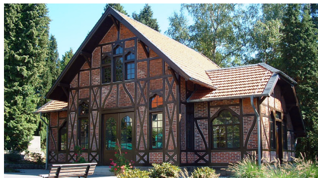
Kolumbarium ‚Alte Einsegnungshalle‘ auf dem Friedhof Dudweiler
